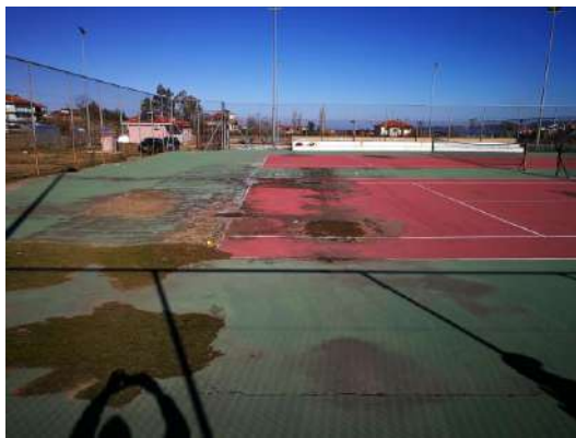
Φωτο. 5,6,7&8 Εμφανείς οι εκτεταμένες φθορές των δαπέδων των γηπέδων λόγω της αδυναμίας απομάκρυνσης των ομβρίων υδάτων (Νέα Ρόδα)
