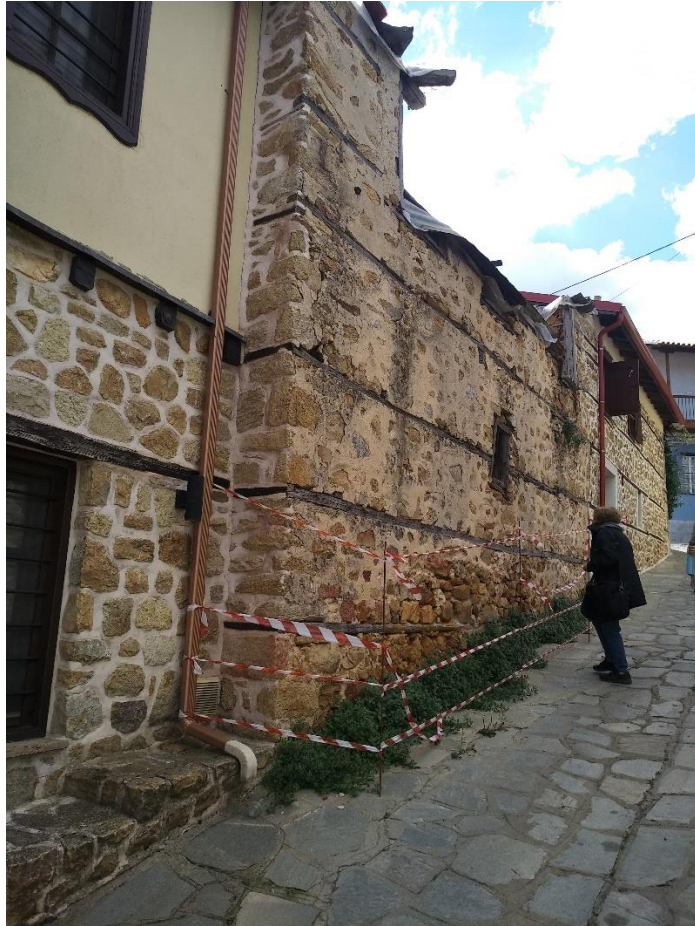
Φωτ. 4 Δυτική πλευρά του κτίσματος
